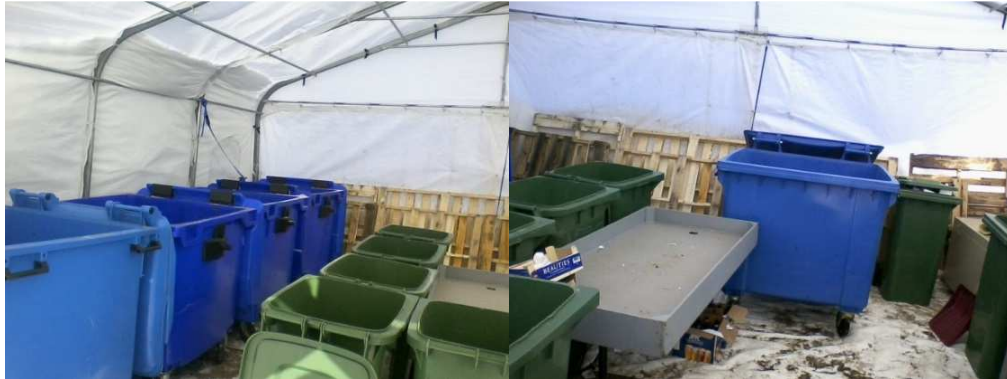
Photographie 2 : Centre de tri et d'entreposage des matières résiduelles recyclables en février à l'UQAC
