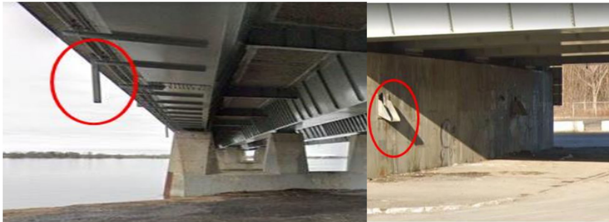
Drains présents sous le tablier
