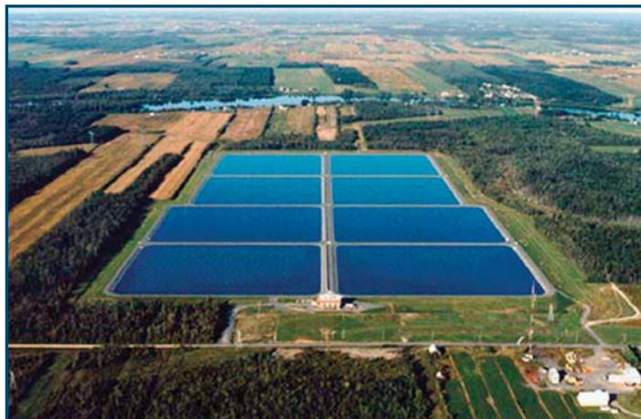
Station d'épuration des eaux usées de Drummondville
