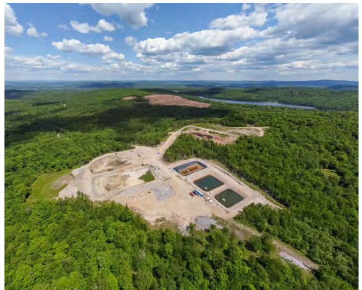
Vue aérienne du site de démonstration de Nouveau Monde. © Nouveau monde
