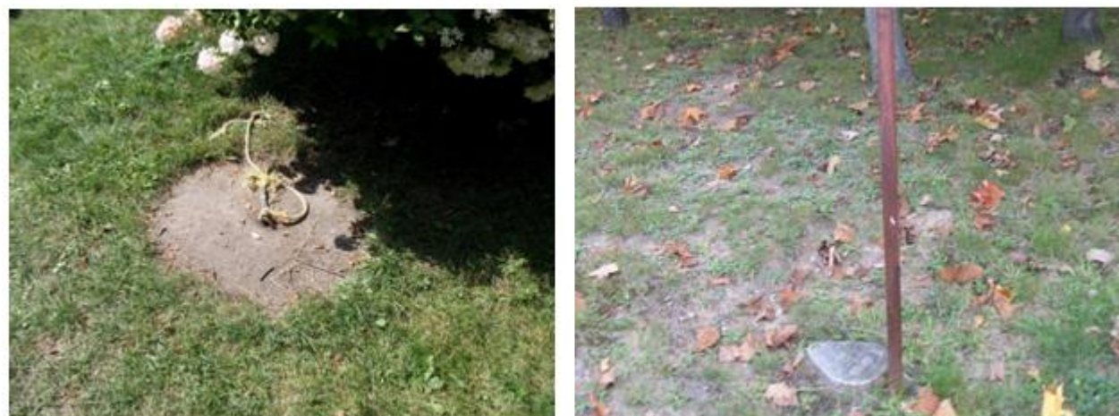
Exemples de puits vulnérables à la contamination microbiologique
