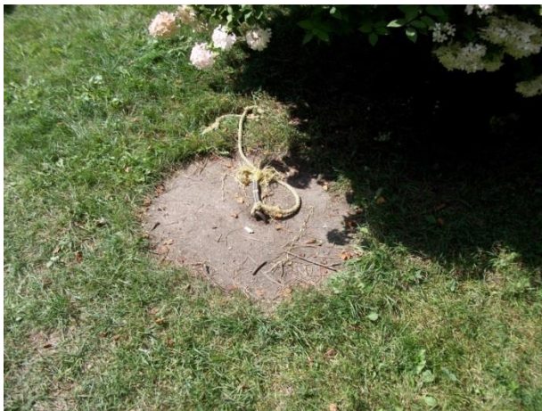
Exemples de puits vulnérables à la contamination microbiologique
