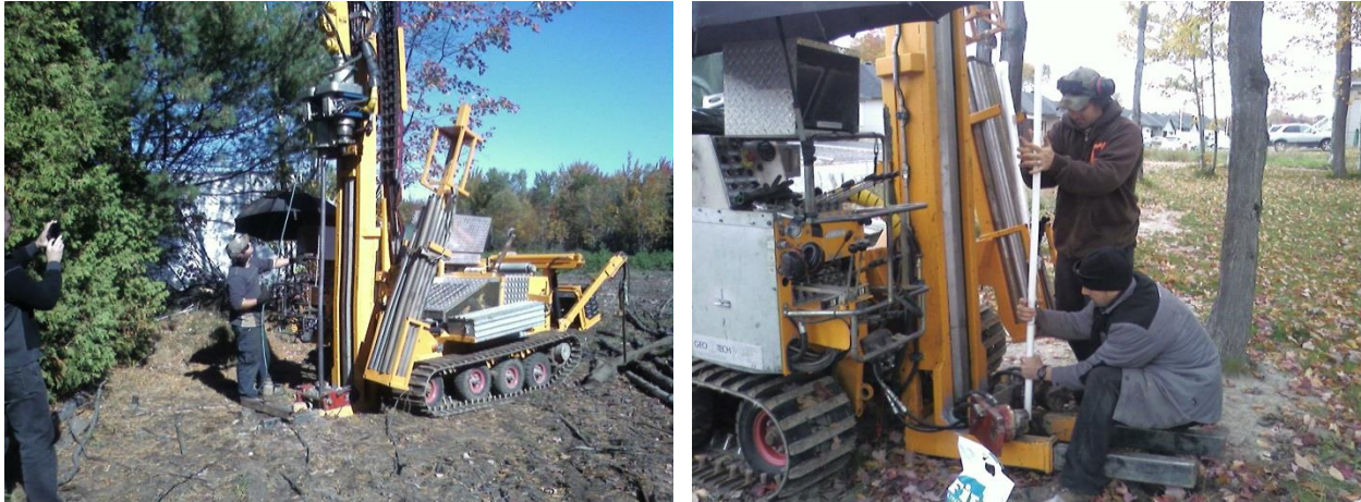
Réalisation des essais de pénétration au cône
