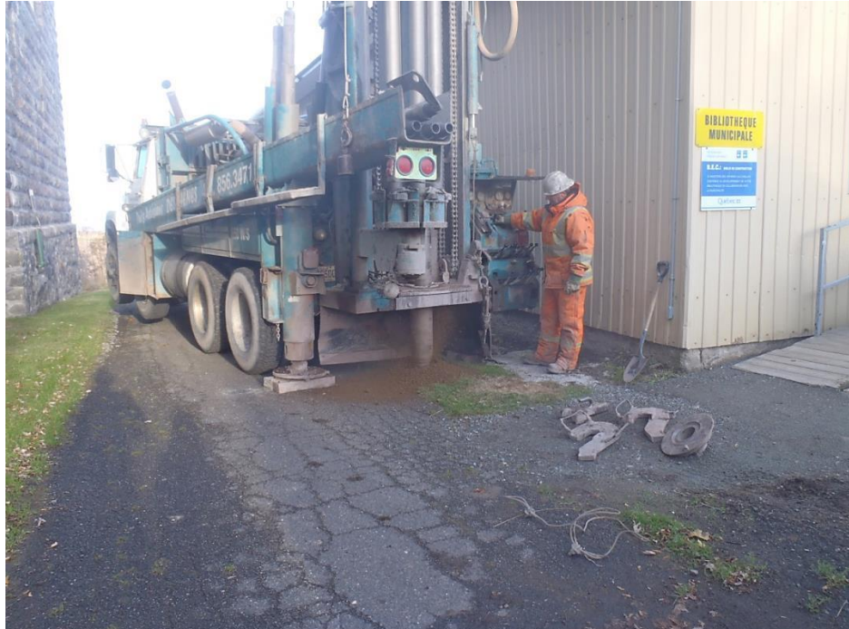
Figure 3.5. Forage de l'aquifère rocheux dans la municipalité de Saint-Éloi
